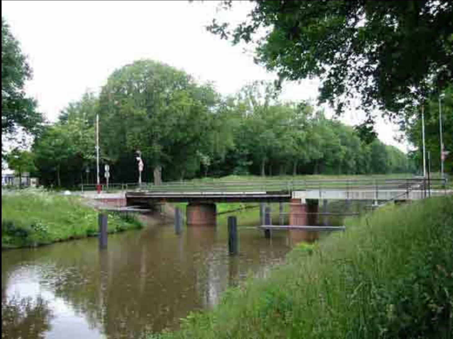
Drehbrücke: Sanierung, Automatisierung notwendig
