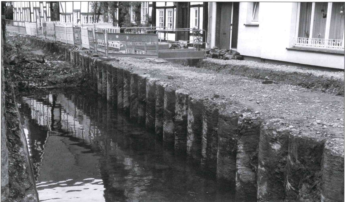
Bohrpfahlwand am Gewässer – ein aufwendiges Unternehmen.
