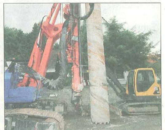
Ein Tag Zwangspause. Weil auch die Schablonen für die Löcher-Bohrungen durch den heftigen Regen zugehauen waren und verdrückt wurden, konnte gestern am Loerbach nicht gebohrt werden. ■ Foto: Niggemeier
