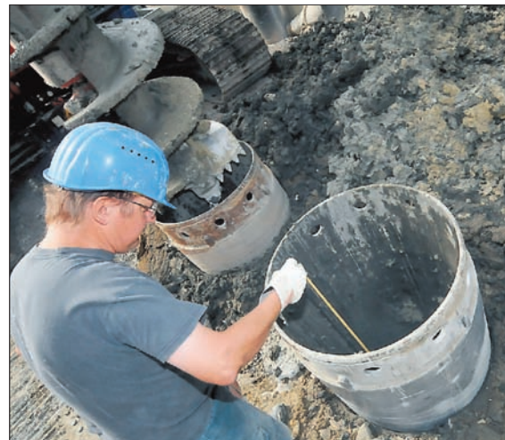
Passt die Tiefe? Genau nachgemessen wird bei den Bohrlöchern, ob sie tief genug im Boden sitzen.
