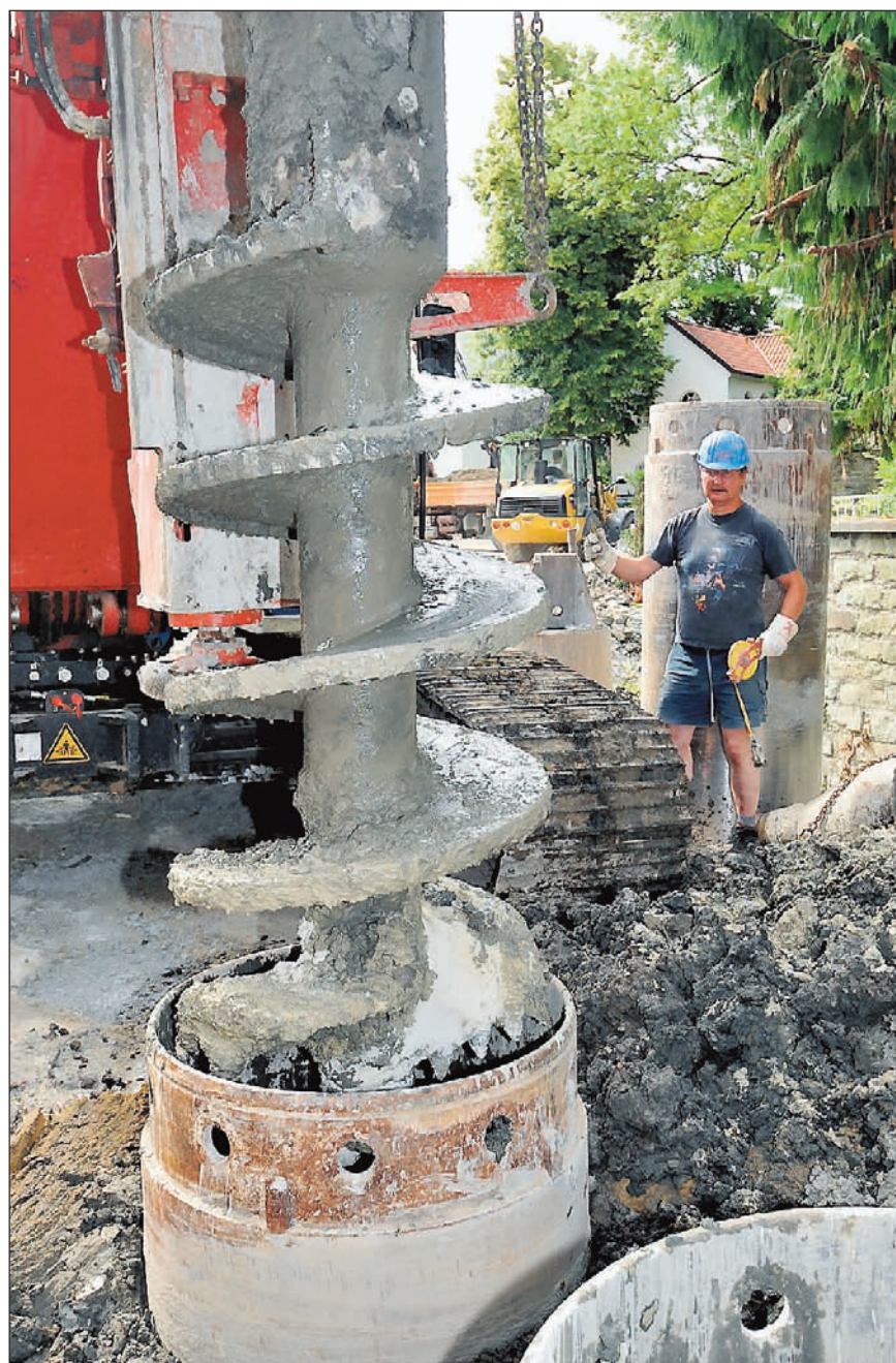
Die große Schlammsschlacht: Der mächtige Bohrkopf mit den kräftigen Hartmetallzähnen frisst sich am Loerbach viele Meter in den Boden und Fels hinein. ■ Fotos (4): Dahm
