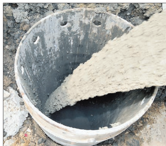
Beton marsch: Wenn das Loch tief genug gebohrt worden ist, wird es mit Beton verfüllt. Anschließend wird die vier Zentimeter starke Stahlbohrrohre wieder herausgezogen.
